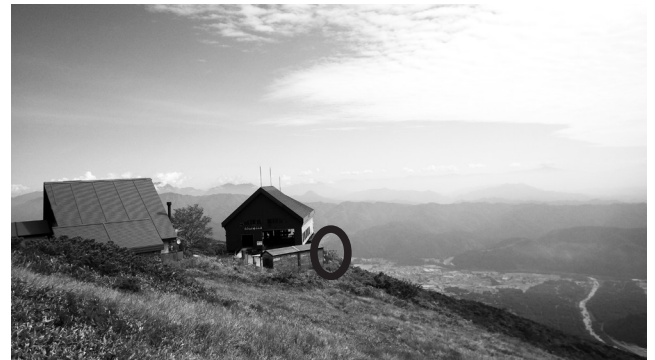
図4 八方池山荘、黒丸内に送信アンテナを設置
